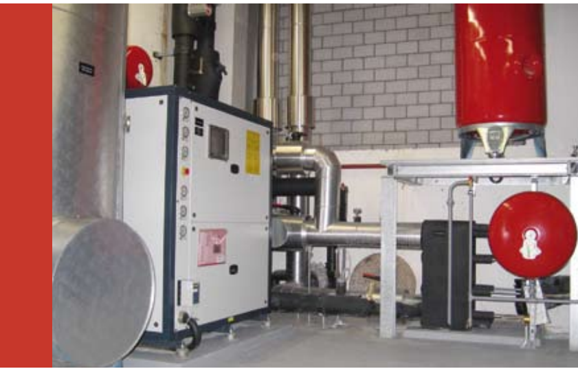
Grundwasser-Wärmepumpenanlage
