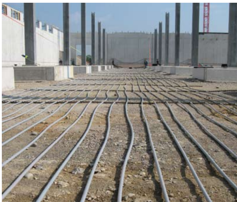
Erdregister unter Bodenplatte
